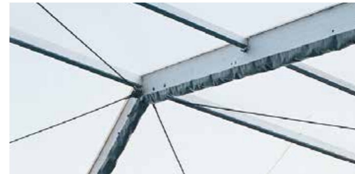
Riegelrinne zur Riegelstoßabdichtung (ab 25 m Spannweite)
